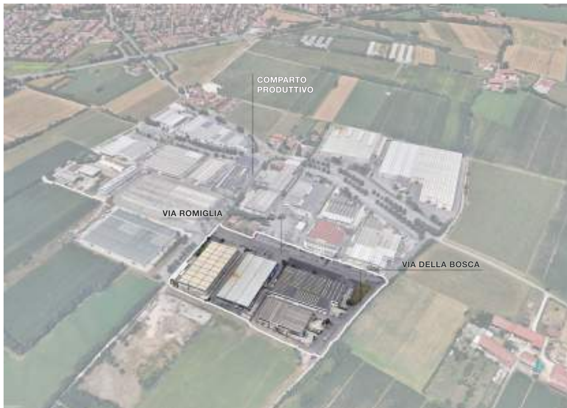
Fig.4.35: Zona di via della Bosca e via Romiglia nel comparto produttivo
