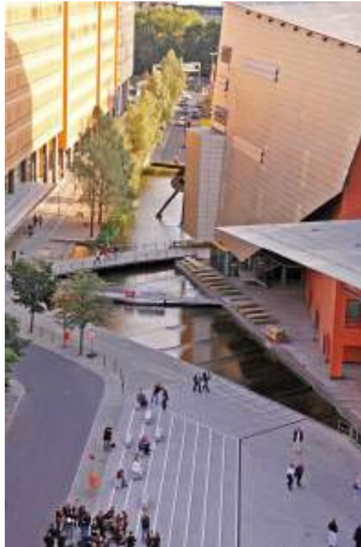
Fig.4.27: Esempio di vasca di laminazione superficiale (Potsdamer Platz, Berlino)
