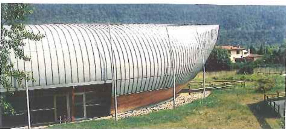
La scuola Antonietti di Iseo utilizza una pompa di calore geotermica da 109 kW dedicata alla palestra e agli spogliatoi, con sistema a circuito aperto, che fa ricorso al calore dell'acqua emunta dalla falda e re-immessa nella stessa
