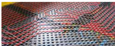
Anche nella scuola elementare di Puianello la diffusione del calore è assicurata da un impianto radiante a pavimento
