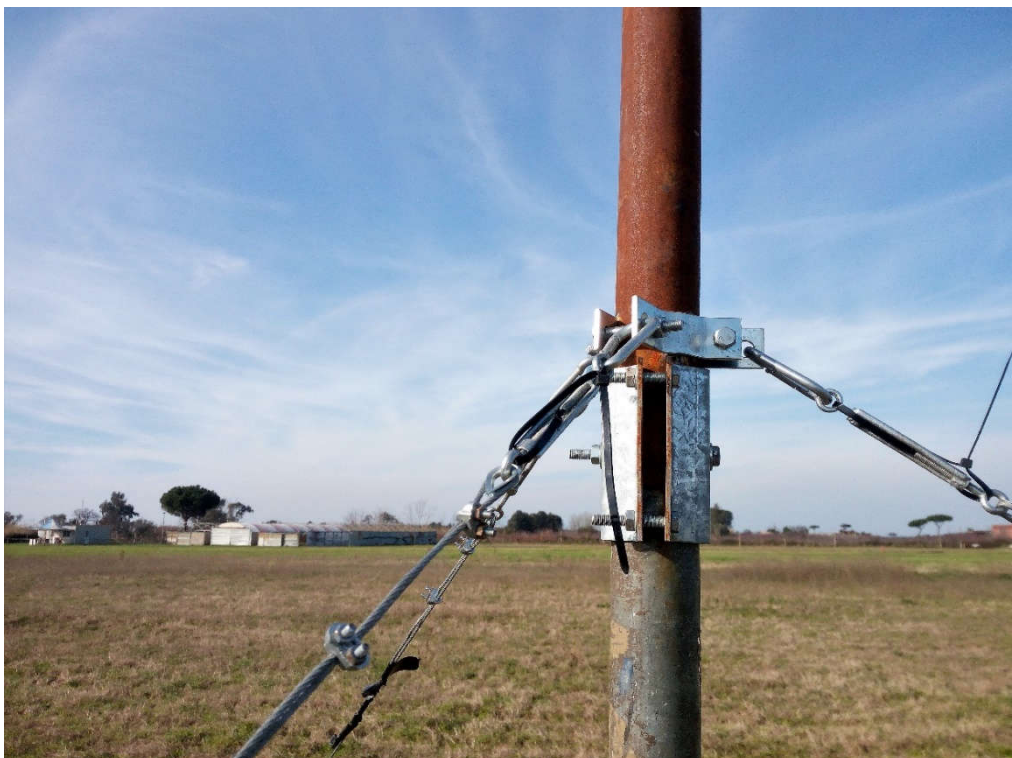
Fig. 6.6: Blocco per evitare lo svitamento dei tendi cavo
