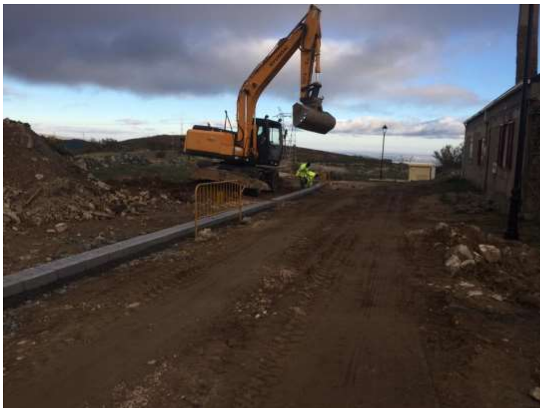
Illustrazione 4.10: Costruzione di una strada a Foncebadón
