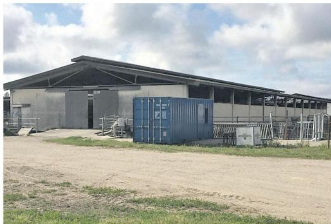
Il capannone che ha ospitato l'impianto sperimentale
