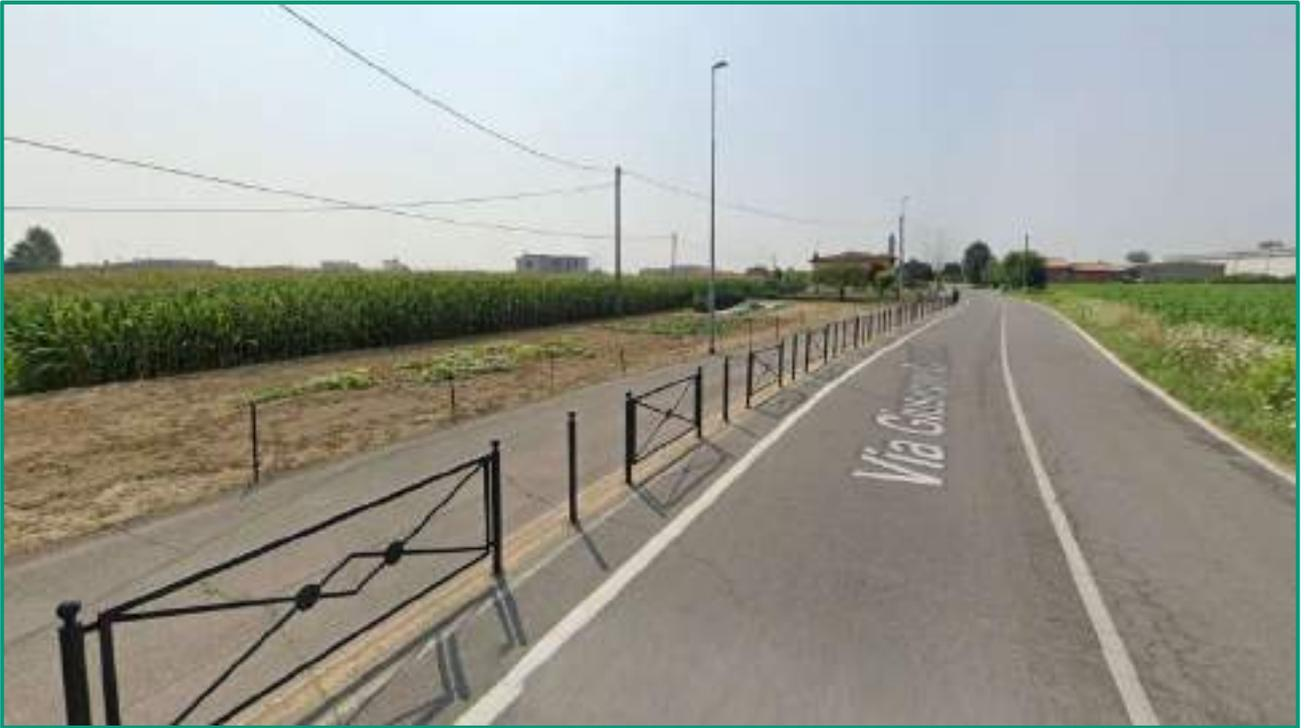
Fig. 23: Esempio di corsia promiscua pedoni-ciclisti con barriera laterale (caso 4/2); il senso è doppio e in questo caso è presente una barriera para pedonale in metallo, mentre altre volte sono presenti cordoli in calcestruzzo, fittoni in metallo, aiuole con presenza di vegetazione (Comune di Mairano, fonte immagine: [www.google.it/maps](http://www.google.it/maps)).
